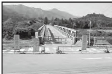
・劣化による橋脚部のコンクリート欠落のため、路面段差が発生し、全面規制実施中。
