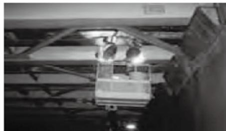
橋梁点検車を使った橋梁点検
