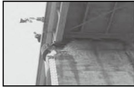
・支承部コンクリート劣化欠損の状況
