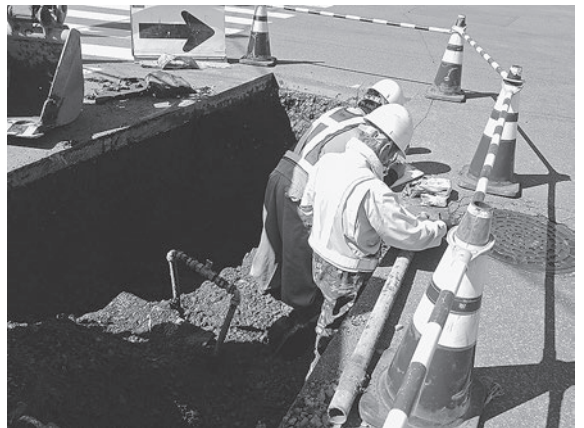
舗装工事の現場でアンケート調査を実施中
